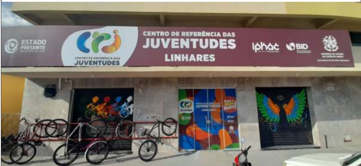
Fachada do CRJ Linhares.
